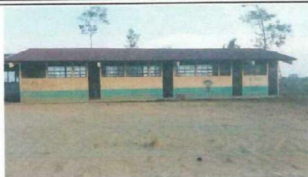
Foto 1: Cambio de techo por deterioro
