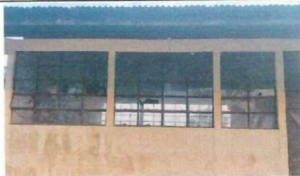
Foto 2: Cambio de vidrio
